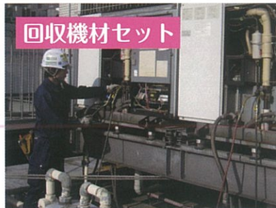
対象機器に回収機材をセット
